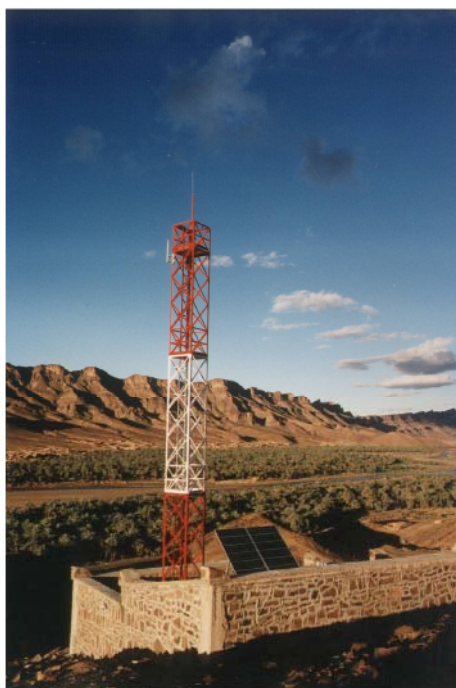
FIGURA 1.3: Sistema fotovoltaico autónomo alimentando un radioenlace.
