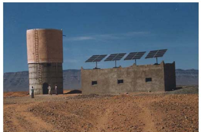
(b) Sistema de bombeo con depósito elevado.
